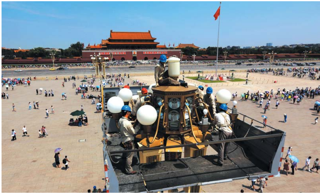
长安街华灯分布在天安门广场和东西长安街两侧,6000多个灯球每年都要清洗一遍。一座华灯清理工作平均耗时15分钟左右,今年华灯清洗检修工作耗时近四个月。
