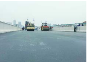
顺河高架南延开始沥青摊铺。
