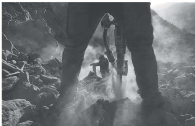
▲2016年12月13日，云南丽香铁路金沙江特大桥的桥墩建设工地上，风钻手正在为桥墩地基打炮眼。
