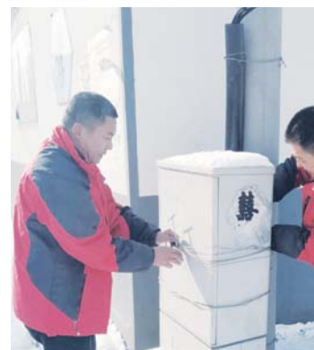
山东有线员工在雪中维修。杨腾 摄
