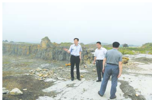
查看废弃矿坑治理现场
