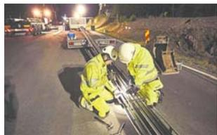
瑞典日前开通了全球第一条电动汽车“充电公路”,可以通过地底铺设的电网为电动汽车充电,是解决电动汽车里程焦虑的一个有效方案。
