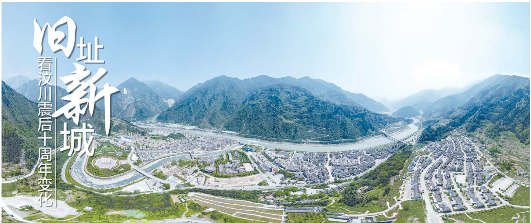
位于震中的映秀镇, 2018年重建后的全景实拍图。
